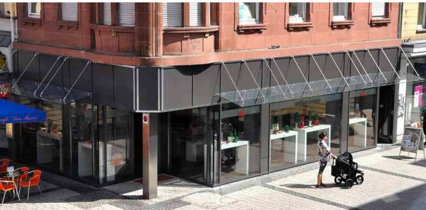
Das 24 Meter lange Zugstangenvordach wurde in nur acht Stunden an der Pfosten-Riegel-Fassade befestigt.
